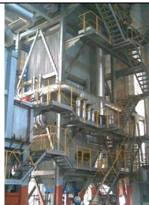
图表 14: 含油污泥干化焚烧项目 (20t/d, 含水率 80%)
