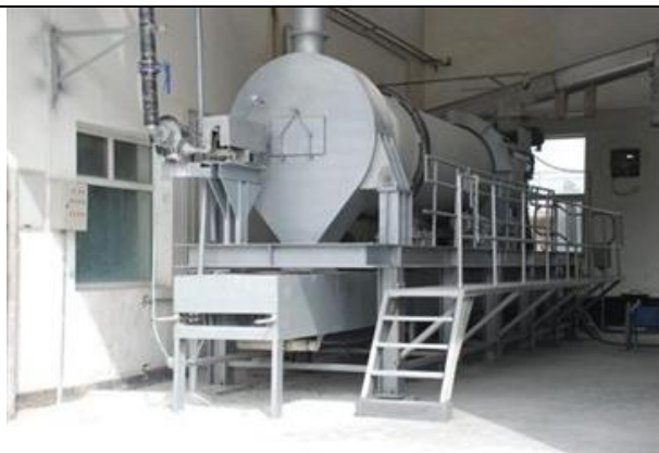
图表 13: 石灰污泥干化项目 (20m 3 /d, 含水率 80%)
